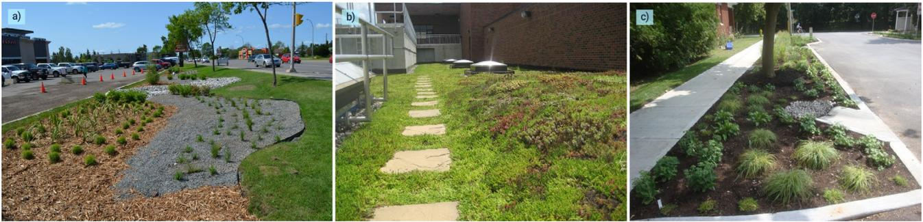
Figure 3.13 : Trois exemples de projets de développement à faible impact. a) Aménagement à faible impact de la biofiltration sur l'avenue Memorial à Thunder Bay. b) Aménagement d'un toit vert à faible impact sur l'usine de récupération d'eau de Lou Romano à Windsor. c) Projet de rigole biologique de l'avenue Alvington à Kingston. Sources : a) Ville de Thunder Bay, 2015; b) Photo offerte par la ville de Windsor, 2014b; c) Photo offerte par la ville de Kingston.
